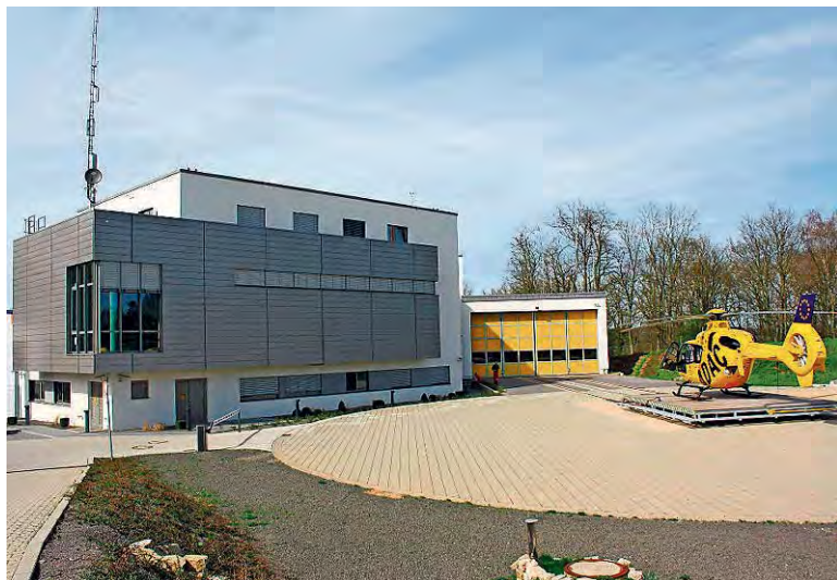
Das Gebäude der Integrierten Leitstelle auf dem Saarbrücker Winterberg. Dort ist auch der Hubschrauber „Christoph 16“ stationiert.
