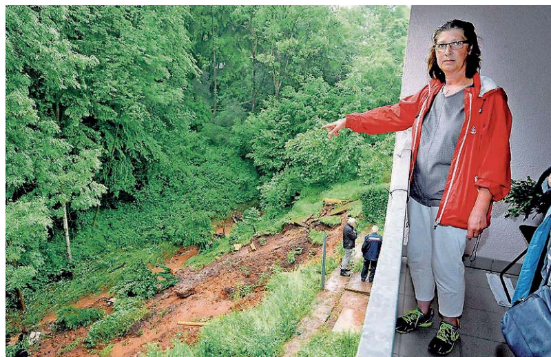
Susanne Giese zeigt auf das Gelände hinter ihrem Haus in der Thalexweiler Straße, wo der Hang abgerutscht ist.
