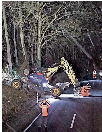
Der extra angeforderte Schreitbagger im Einsatz. FOTO: NALBACH
