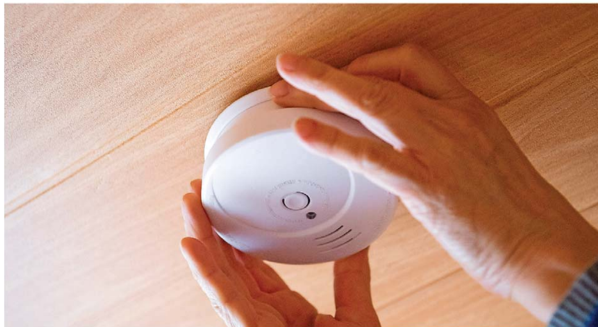
Rauchmelder lassen sich mit dem Gerät beiliegenden Schrauben und Dübeln oder einem dafür vorgesehenen Klebe- oder Magnetpad montieren. FOTO: ANDREA WARNECKE/DPA
