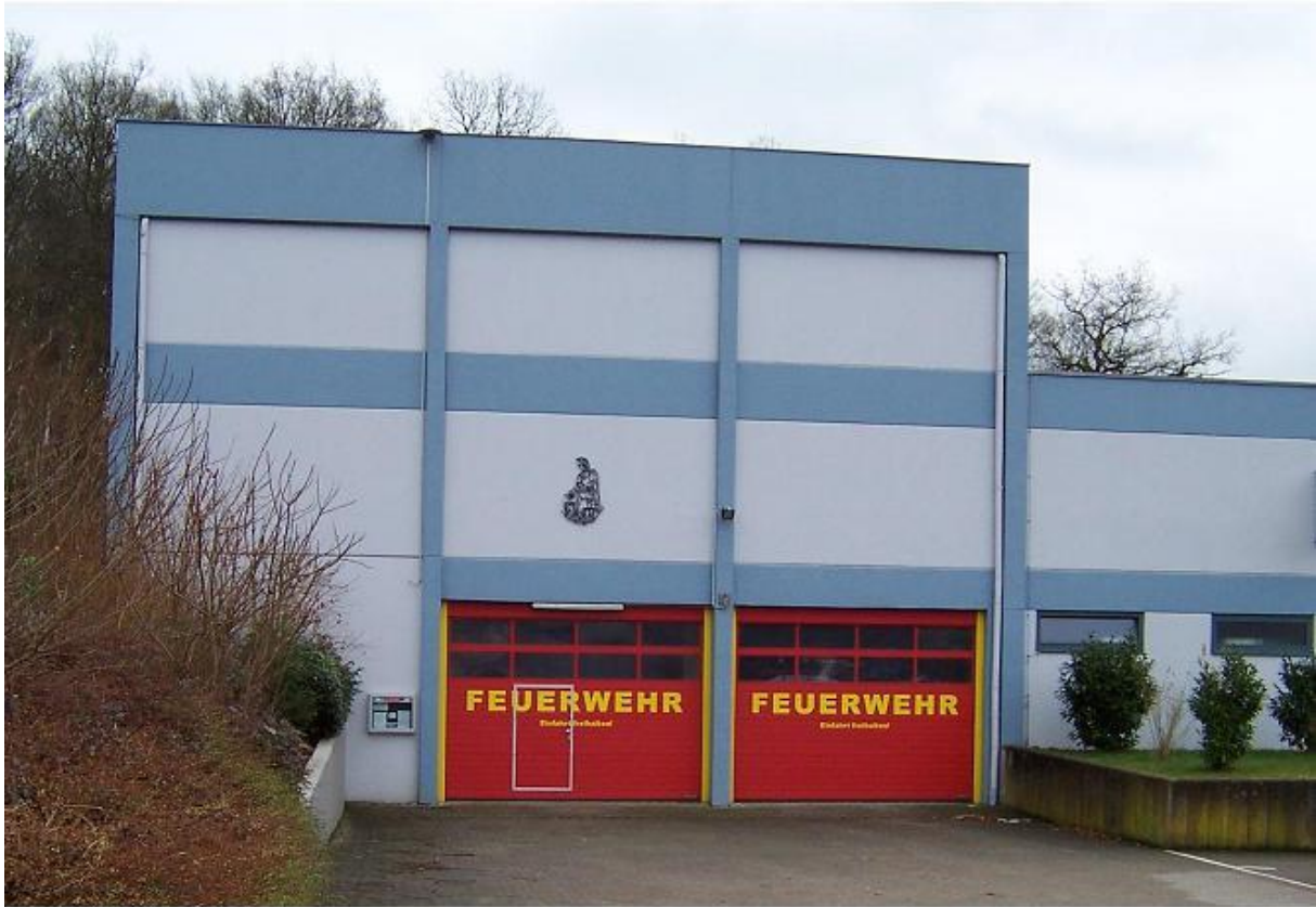
FEUERWEHRGERÄTEHAUS IN DER STANGENWALDHALLE
