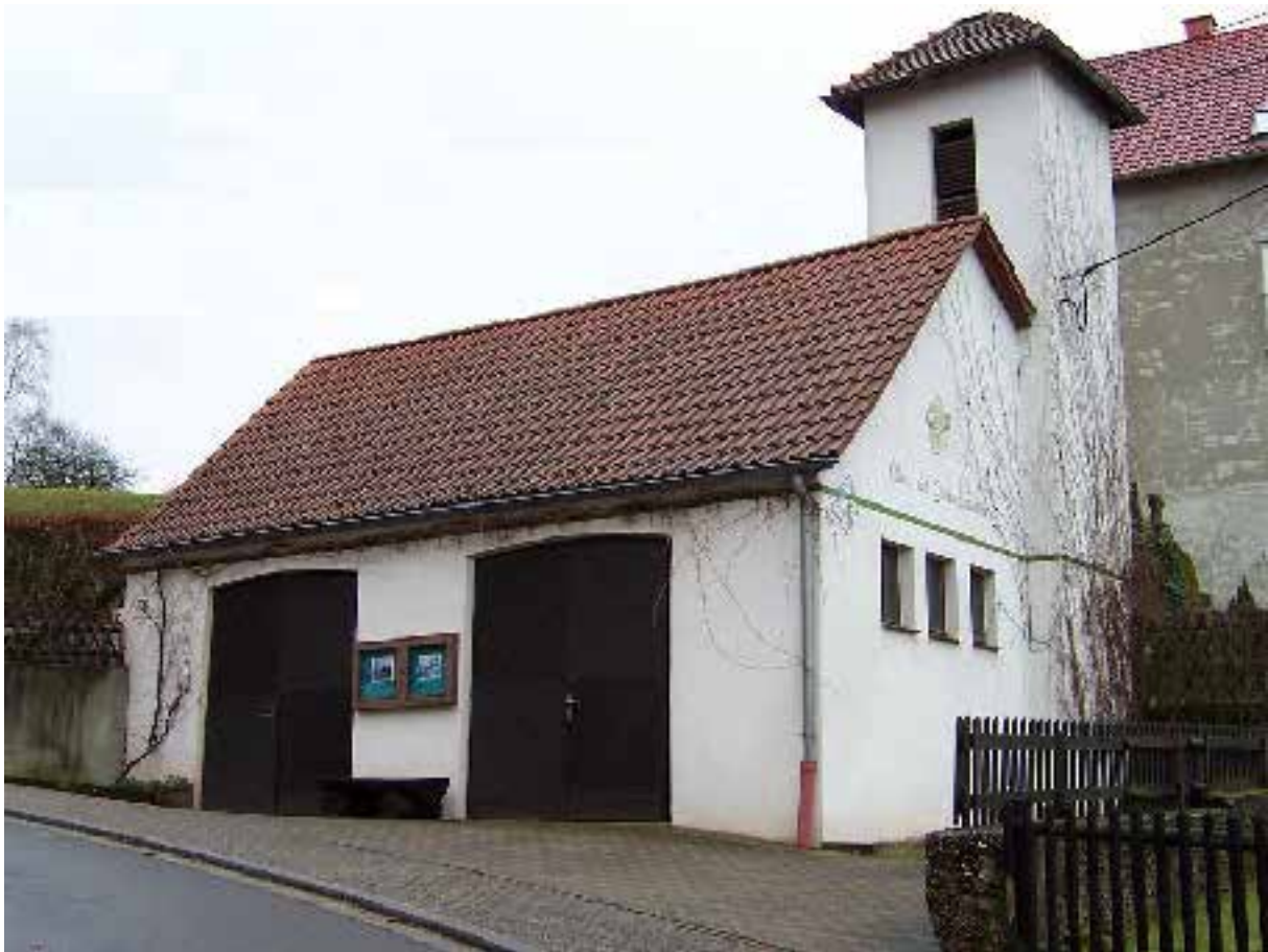
ALTES GERÄTEHAUS IN DER STRASSE ZUM HANGENBERG
