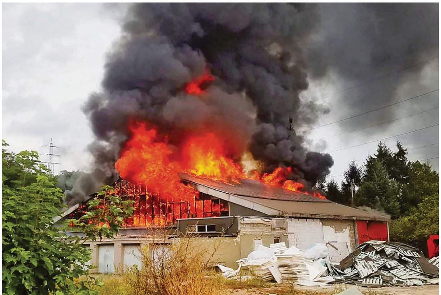
Die Flammen erfassten die komplette Hallenfläche. FOTO: BECKERBREDEL
