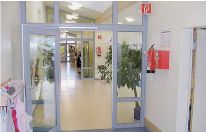
Abb. 8 Rauchmeldergesteuerte Rauchschutztür
