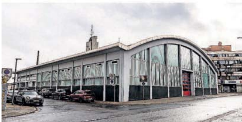
Die Tragwerkskonstruktion des Daches der Feuerwache des Löschbezirks Innenstadt wird repariert.
